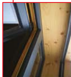
Détail précadre épiceá sans finition avec volet roulant
